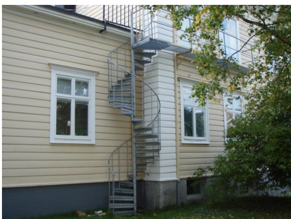
Figur 6: Påbyggnadens anslutning mot Gamla rådhuset
