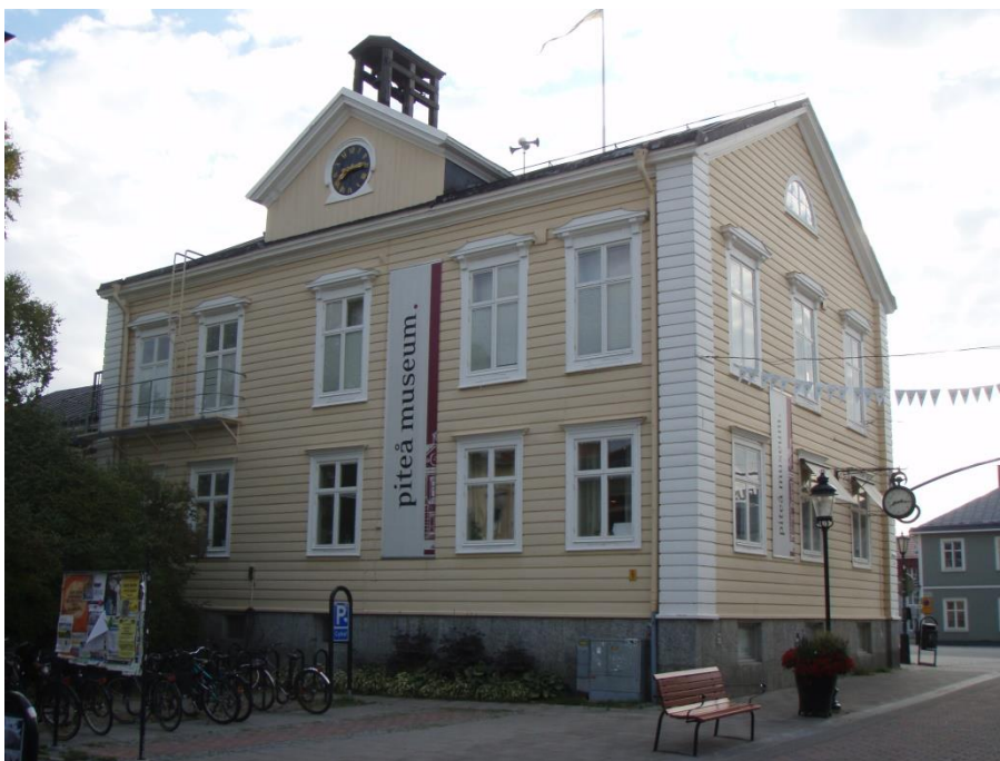
Figur 5: Baksidan av Gamla rådhuset
