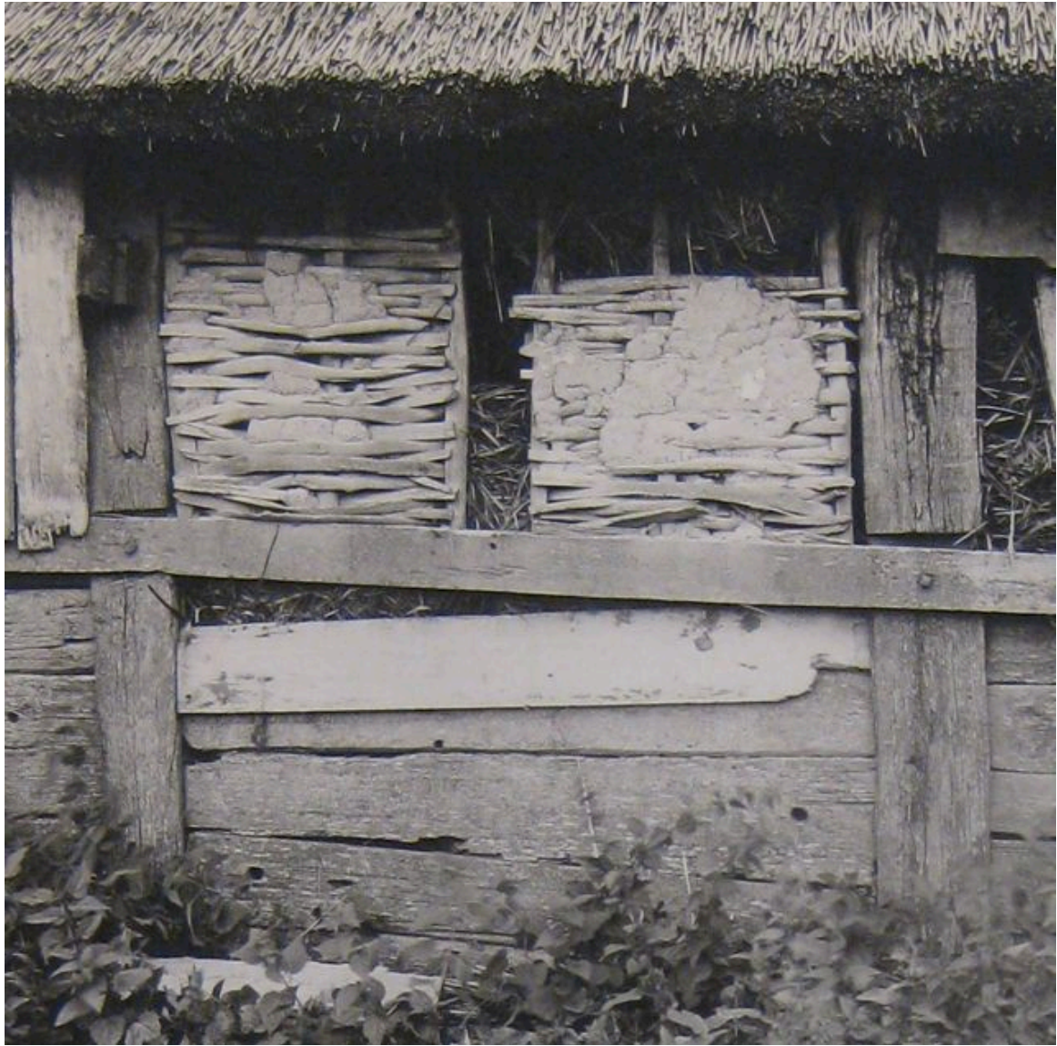
Bild 6. lerstakar med flätverk av vidjor och halm, som sedan klätts med lera och halmblandning . Källa: Melin, Karl-Magnus. Hantverkskunskap rörande skånsk byggnation med lera på landet . Rapport. Kristianstad: Knadriks Kulturbygg AB, 2011. s. 16.
