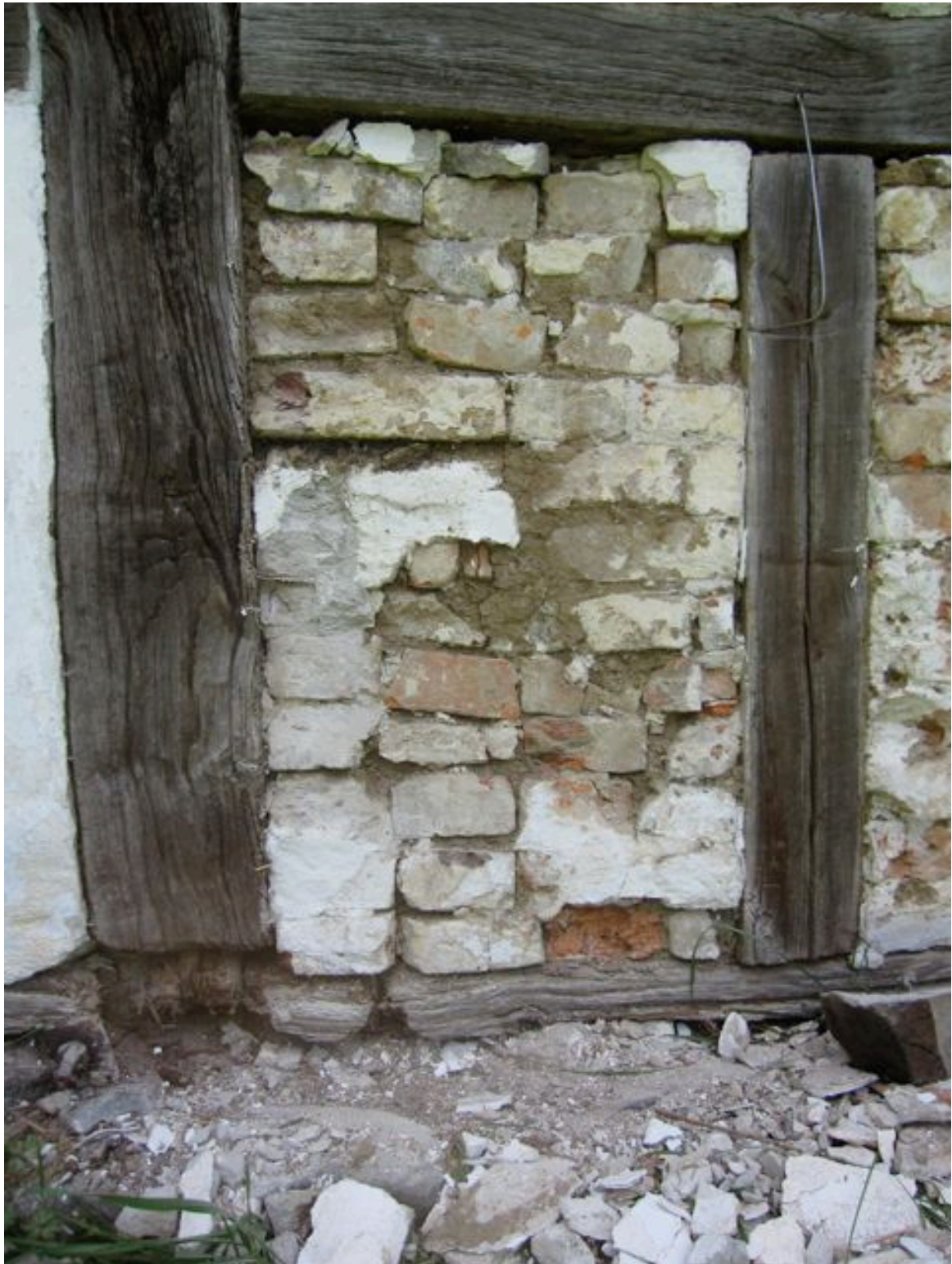
Bild 2. Begagnat bränt tegel i fackverk på Bondrumsgården. Källa: Melin, Karl-Magnus. Hantverkskunskap rörande skånsk byggnation med lera på landet . Rapport. Kristianstad: Knadriks Kulturbygg AB, 2011. s. 15
