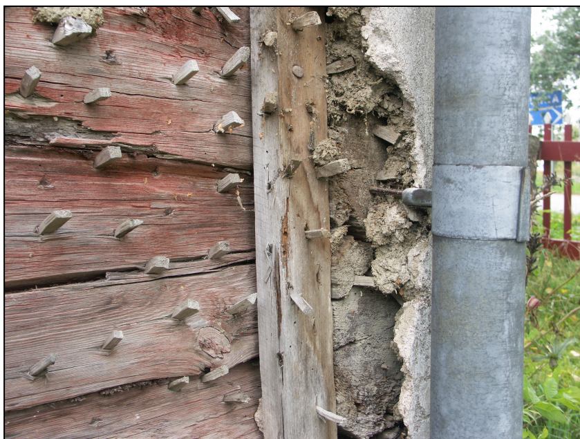
Bild 19. Utvändig lerklining på timmerstomme med en ytputs av kalkbruk. Notera träpliggarna som täcker hela timmerstommen för att leran ska ha något att fästa på. Utstockningen med lera är här ca. 4-5 cm tjock och ytputsen av kalkbruk är ca 1 cm tjock.
