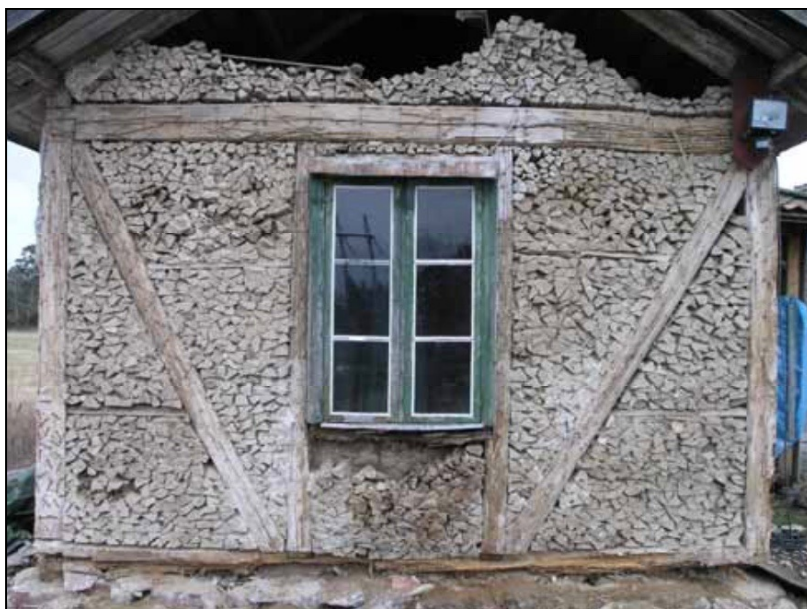
Bild 14. Kubbhus. Bostadshus i Torslunda, Täby socken, Uppland. Uppfört ca. 1870. Noterna träkubbens ändar som syns i fackverket. Fotot är taget innan restaurering för att visa konstruktionen. Efter restaurering är huset reveterat utvändigt. Källa: Stockholms länsmuseum. http://old.stockholmslansmuseum.se/site_media/upload/2010_4_TorslundaLow.pdf , hämtad 2017-05-09.
