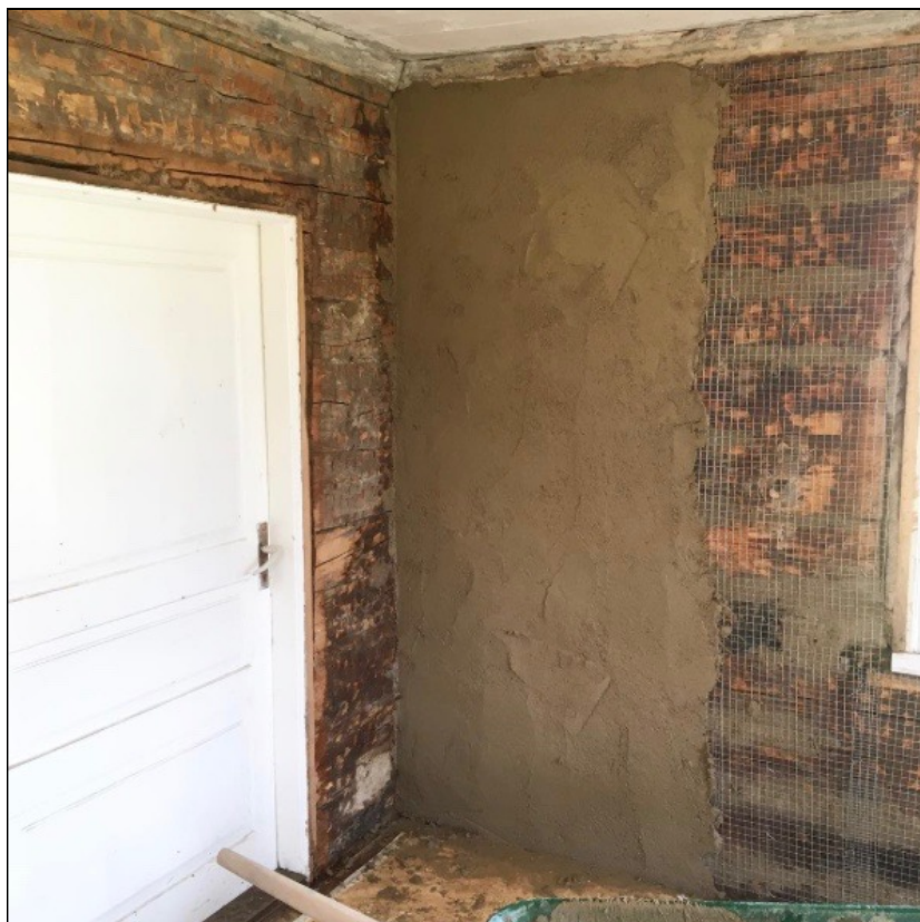
Bild 21. Pågående lerklining av timmervägg invändigt. Här används putsnät för att lerbruket ska få bättre fäste i väggen. Notera att såten har en utstockning som gjorts innan putsnätet sattes upp på väggen.
