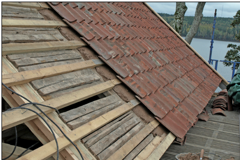
Bild 20. Tegeltak som har ett tätskikt av lera. Notera späckpanelen som ligger mellan facken och lerbruket som lagd ovanpå den innan teglet läggs. Foto: Västergötlands museum.
