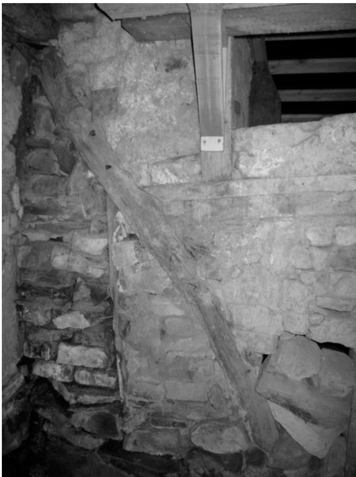
Bild 3. Fackutfyllnad i form av otuktad sten. Källa: Melin, Karl-Magnus. Hantverkskunskap rörande skånsk byggnation med lera på landet . Rapport. Kristianstad: Knadriks Kulturbygg AB, 2011. s. 17.
