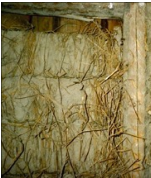
Bild 17. T.v. En klibbstake så som den ser ut innan den sätts dit i taket. Notera den omlindande halmen som är översmetad med lera.
