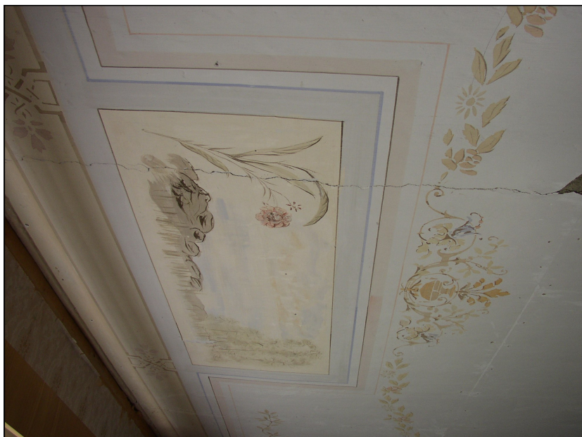
Bild 22. Lerklinat innertak på gården "Hökars" i Ingesarven, mellan Hudiksvall och Bergsjö, bemålat med skira blommor och inramningar. Foto: Daniel Olsson, Länsmuseet Gävleborg, 2004-06-02.
