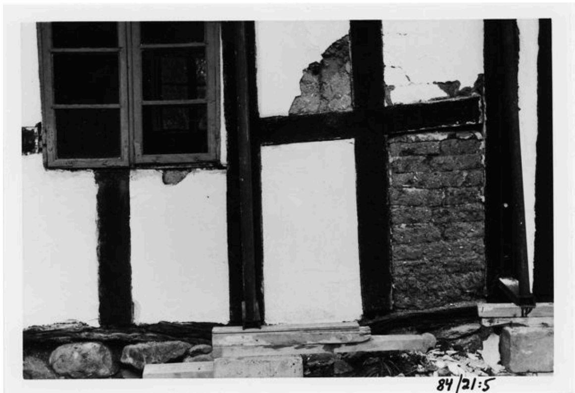
Bild 1. Ett fackverk med lersten. Källa: Melin, Karl-Magnus. Hantverkskunskap rörande skånsk byggnation med lera på landet . Rapport. Kristianstad: Knadriks Kulturbygg AB, 2011. s. 15.
